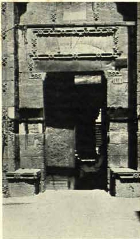
FIG. 181. CAIRO Doorway in Sharia An-Nahhāsīn
