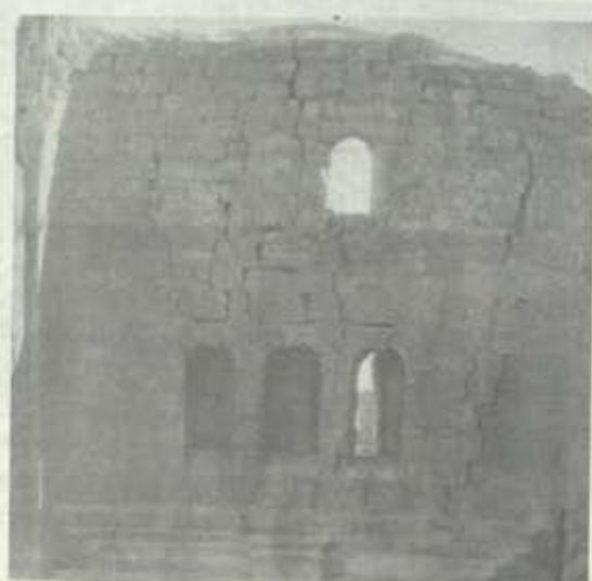
Abb.12 Orthophoto der Hauptapsiswand der Basilika A (hergestellt von der Firma Wild/Heerbrugg mit OR-1 Avioplan), Maßstab ca.1:60
